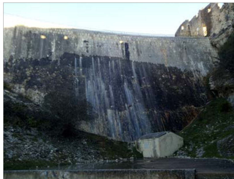
Barrage de Saint-Saturnin-les-Apt (DREAL)
