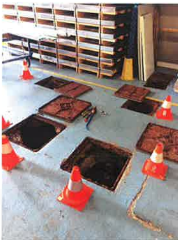
Emplacement du prétraitement
